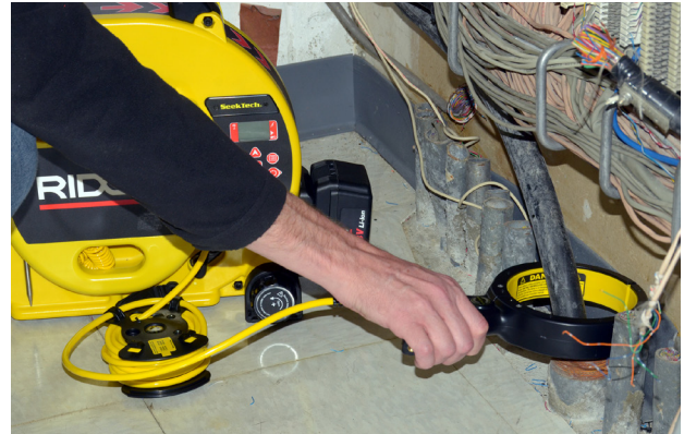
Рисунок 11 – Индукционный зажим в использовании
